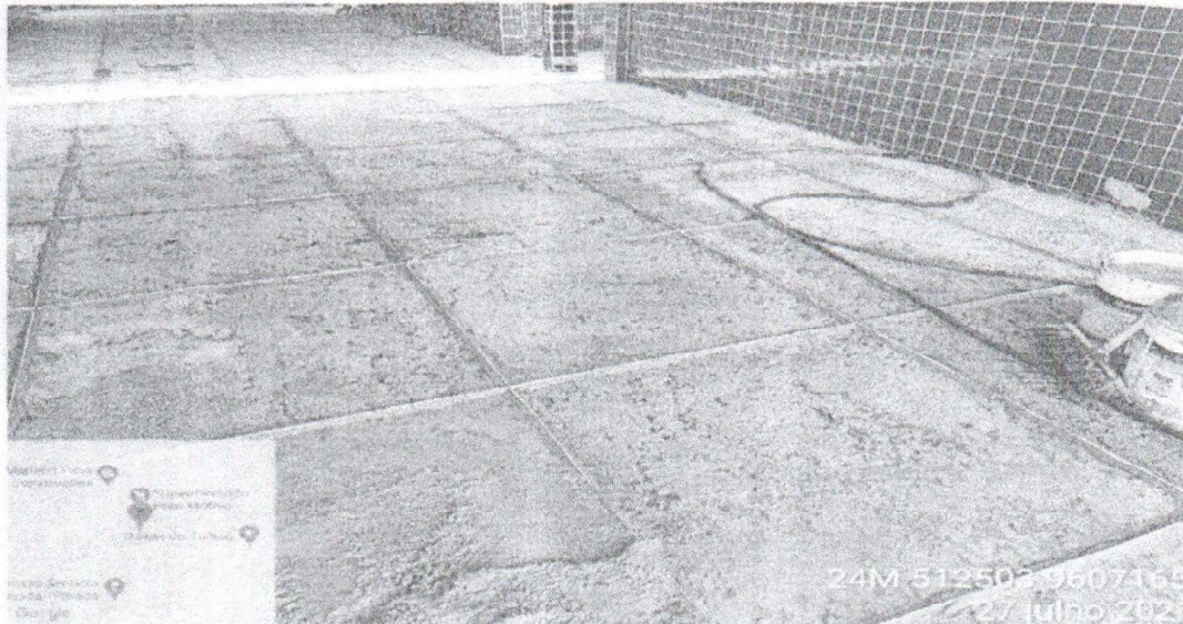
FOTO PRÓPRIA: FITA DE DILATAÇÃO EM CIMA DO LASTRO DE CONCRETO
