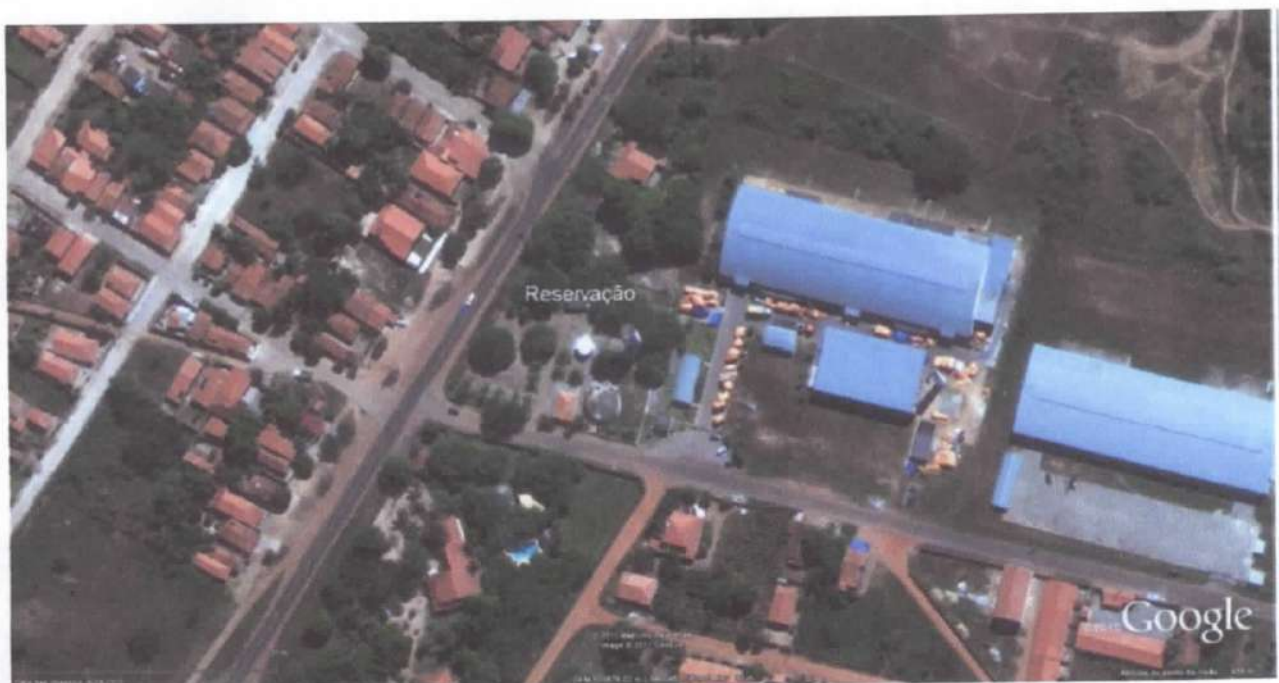
Figura 5-4: localização da Reservação de água potável do distrito Sede. Fonte: CONEN, sobre imagem do Google Earth.
