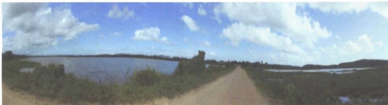
Figura 4-32: montagem de vista panorâmica da barragem de Siupé. Autor: FRANCO, 2011.
