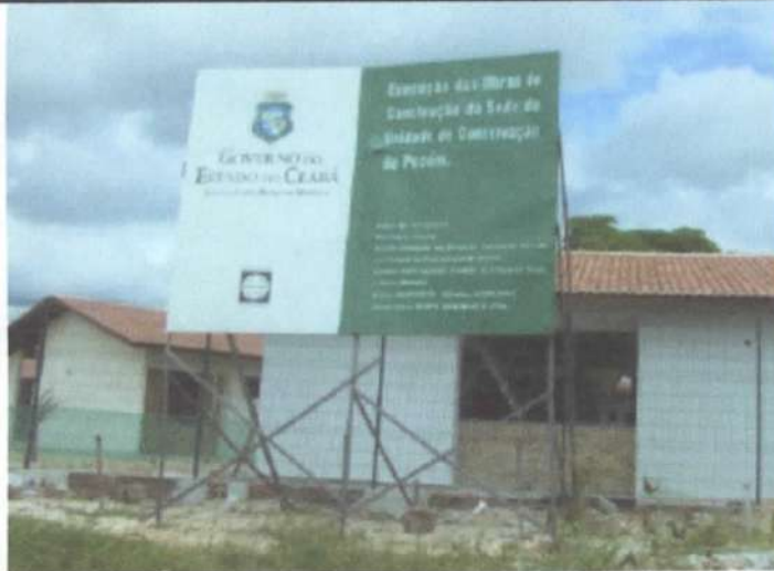
Figura 4-26: obra do Governo do Estado em Pecém. Autor: BUCHWEITZ, 2011;
